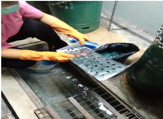
รูปที่ 2-9 แสดงการตัดไขมันออกจากถังดักไขมัน
